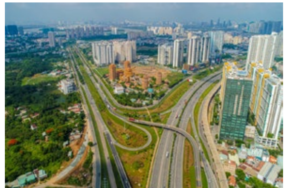
Hình 6. Đường vành đai 2
